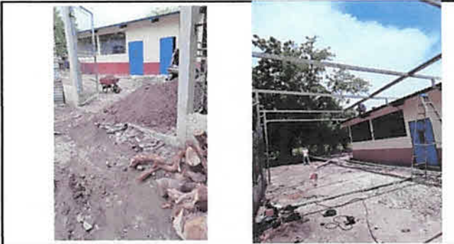
REALIZACION DE GALERA
