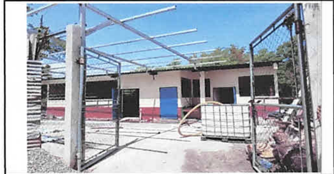
REALIZACION DE GALERA
