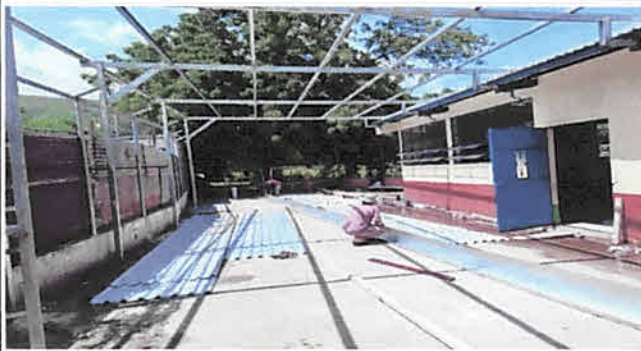
REALIZACIÓN DE GALERA
